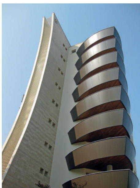
Costruzioni di vacanze simpri plui futuristichis
