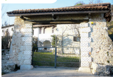
Un portâl ristrutturât
