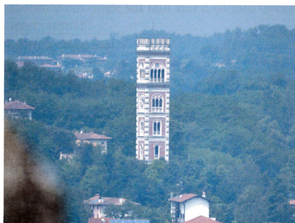
Il campanile-torre di Cassacco( foto G. Barberi)
