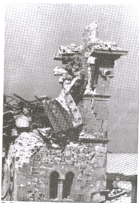
Crollo causato dal terremoto del 1976 e...
